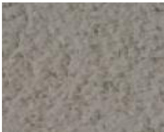
Rysunek 7. struktura tynku cienkowarstwowego US32 lub US93 o strukturze „ baranka”.
